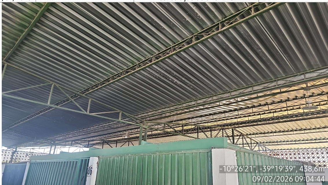
Foto 11 – Registro das tesouras e terças da cobertura
