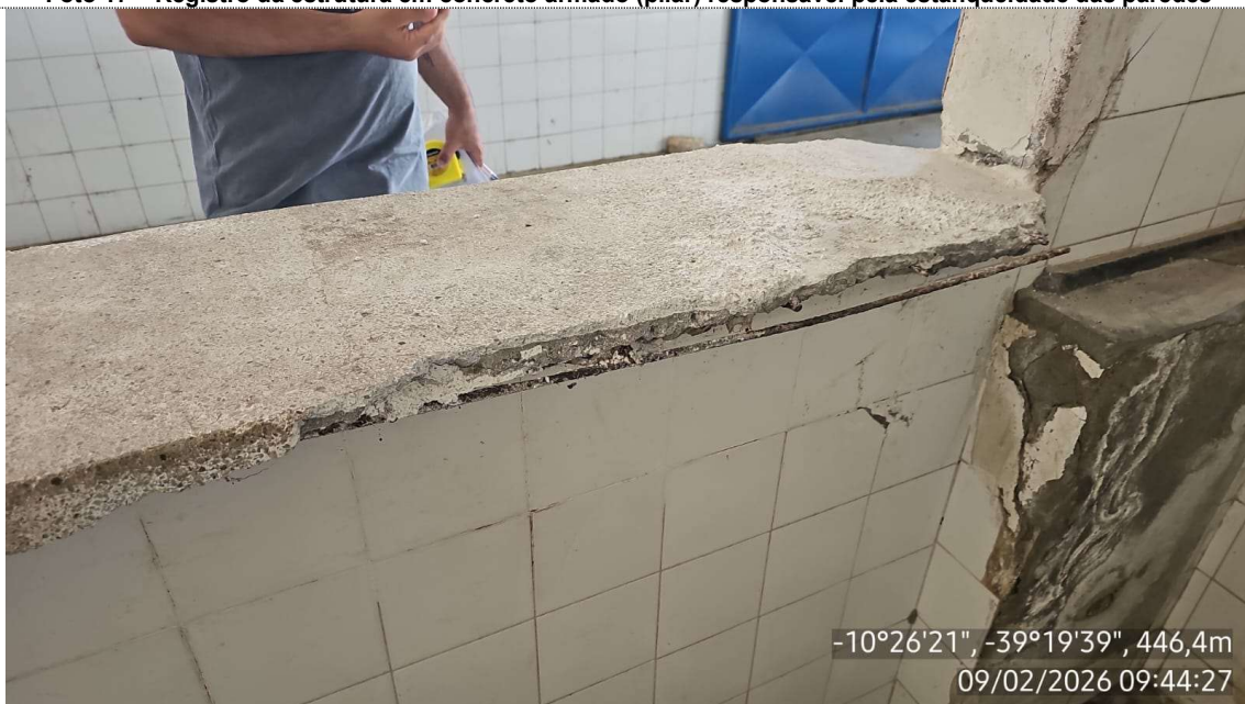
Foto 17 – Registro da estrutura em concreto armado (pilar) responsável pela estanqueidade das paredes
