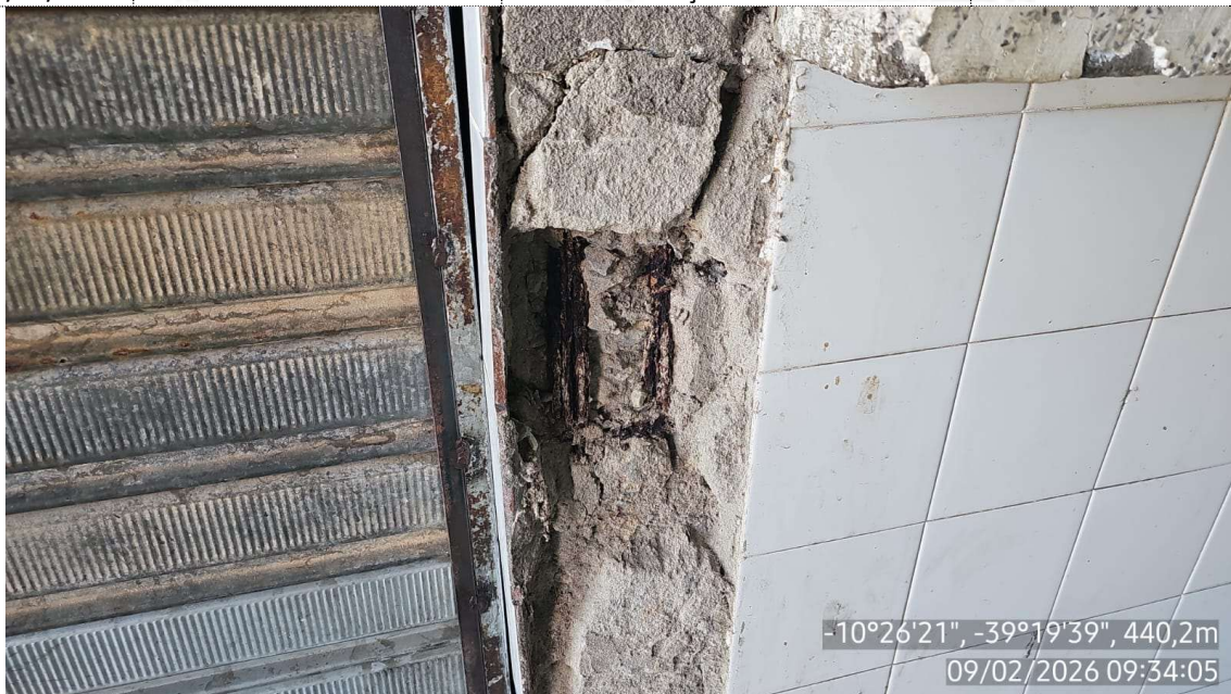
Foto 17 – Registro da estrutura em concreto armado (pilar) responsável pela estanqueidade das paredes
