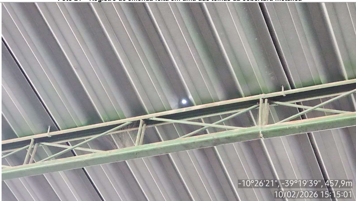
Foto 21 – Registro de emenda feita em uma das telhas da cobertura metálica
